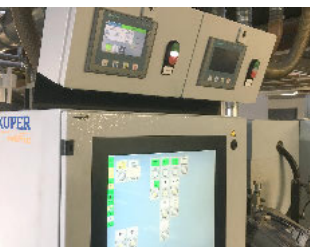
Links über der Maschinensteuerung ist das Panel vom linken Kantenking, das des künftigen rechten ist bereits vorbereitet
